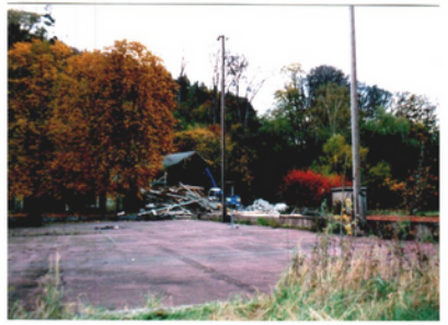
Abriss der alten Anlage
